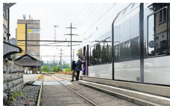
Vor dieser Hürde sollen Menschen mit Beeinträchtigung im Bahnhof Arnegg nicht mehr stehen: der erhöhte Zugeinstieg bei Gleis 2.
